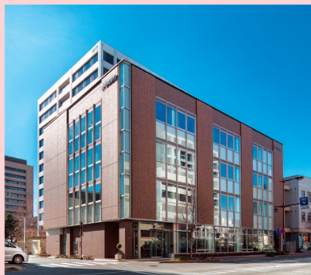
ながぎん長野センタービル完成
